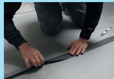
Assurer l'étanchéité avec la bande StickelFoam 25/70 fournie
