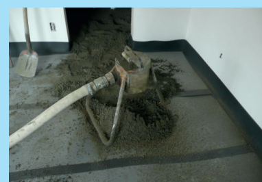
Réaliser une chape renforcée de ± 8 cm d'épaisseur sur le Bi+20
