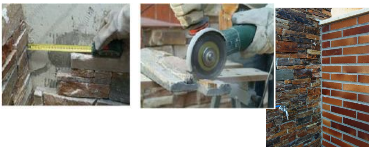
Figure 7 – Réalisation d'un angle rentrant
