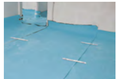
(3) Remonter de \pm 10 cm contre les murs avant de réaliser la chape
