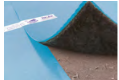
(1) Dérouler l'insulit 4+2 avec un recouvrement de 5 à 10 cm
