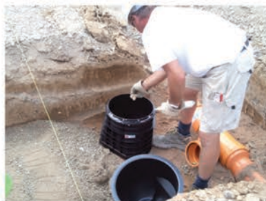
Préparation des éléments supérieurs en appliquant du lubrifiant avant la mise en place.
