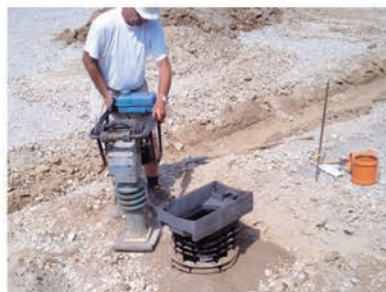
Tassement à l'aide d'un outil léger jusqu'au repère de niveau inférieur de béton sur l'élément en plastique supérieur.
