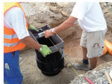
Règlage optimal du dispositif d'écoulement et de l'avaloir grâce au montage télescopique et orientable et adaptation au plan longitudinal et transversal
