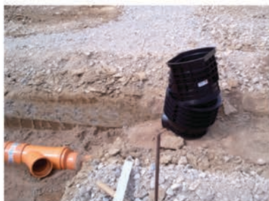
Manipulation aisée sur chantier.
